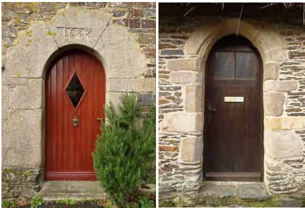
Portes de maisons du 17 e siècle au quartier Notre-Dame. L'alliance du schiste et du granite
